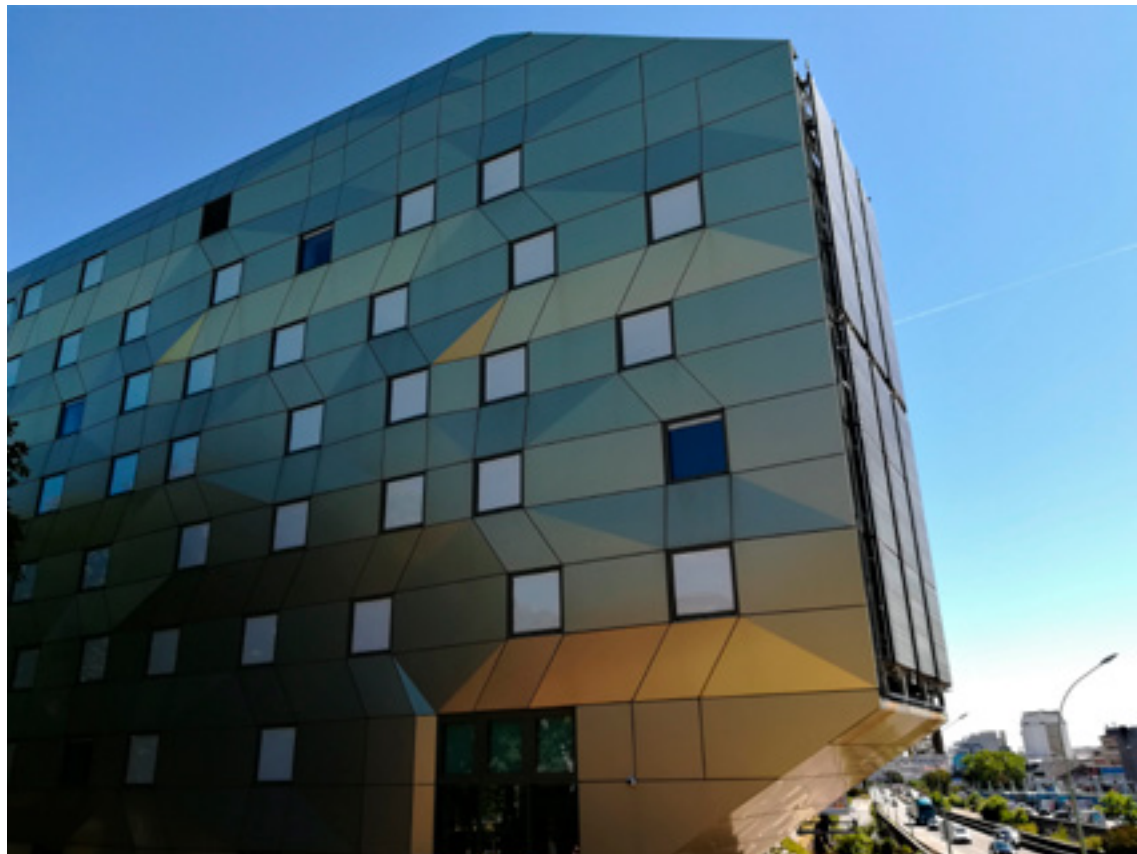
[ Figura 24. Maison de l'Île-de-France. ] Fotografía: Andrés Ávila Gómez, 2020.
