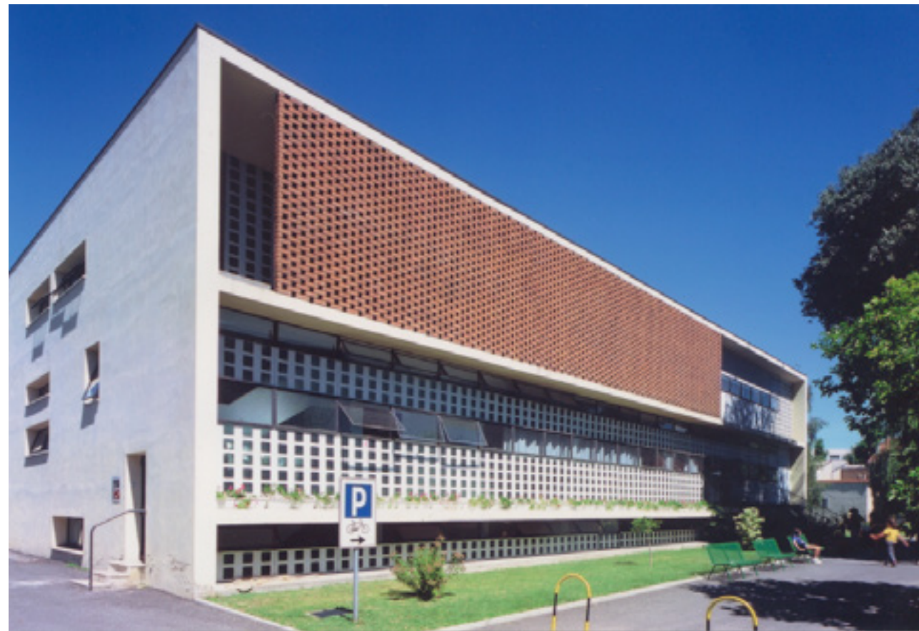
[ Figura 13. Il Dispensario antitubercolare, oggi poliambulatorio Gardella. ]
