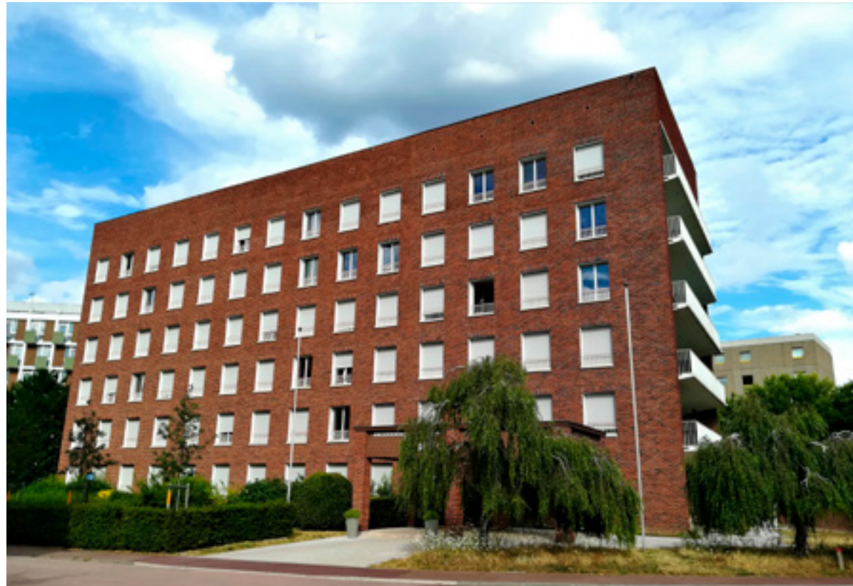
[ Figura 14 y 15. Maison de Norvège. ] Fotografía: Andrés Ávila Gómez, 2020.
