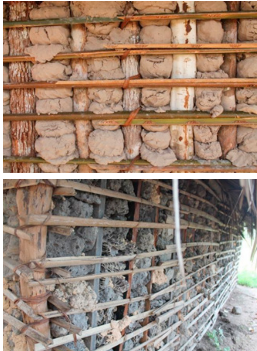
[ Figura 8. Fotos de detalles de distintos materiales usados al realizar la técnica quincha en aldeas Kayapó visitada. ]
