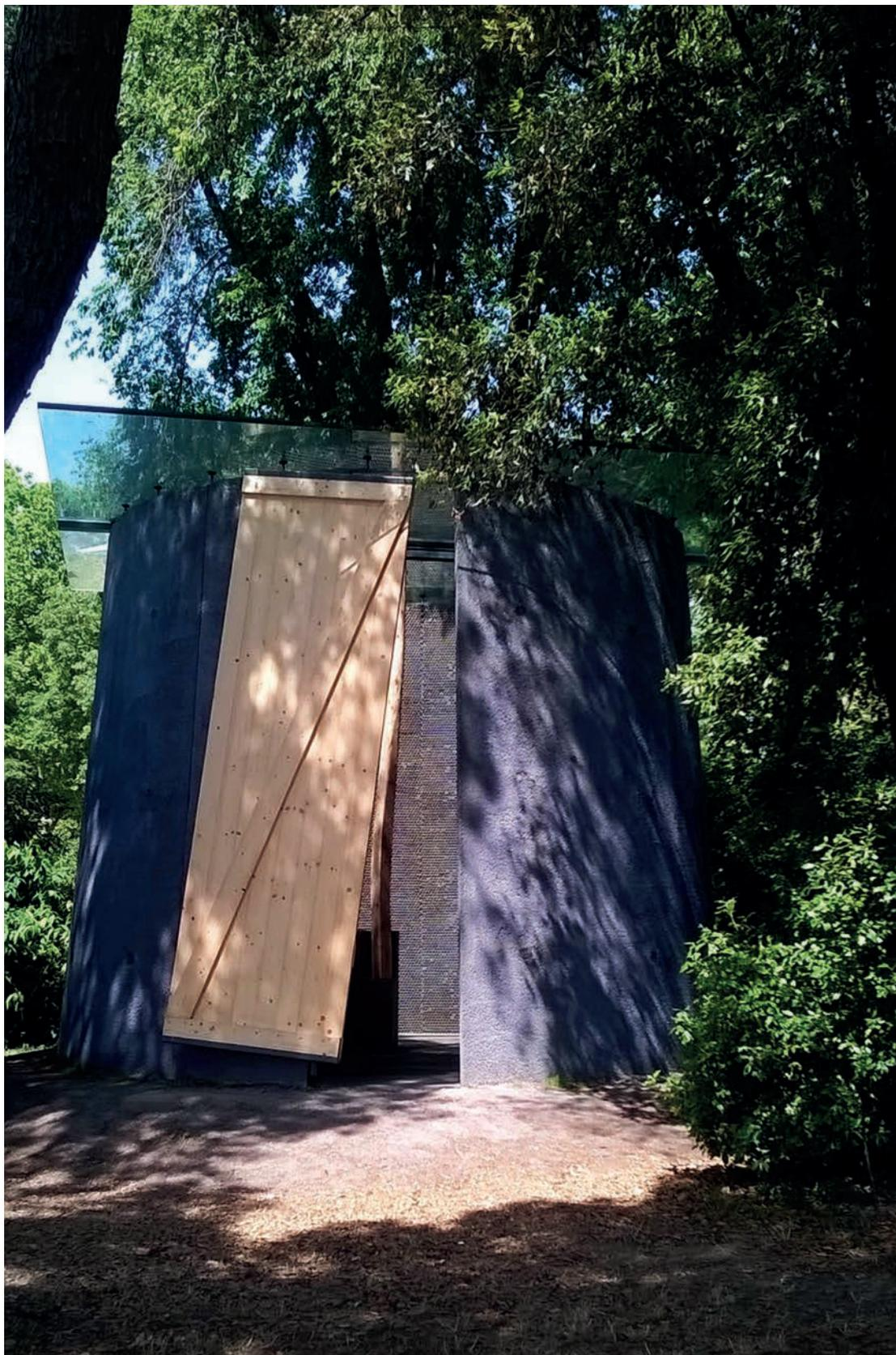
[ Foto 19. La capilla de Smiljan Radic es un cono de paredes finas, con una gran puerta de madera, y el techo cubierto por un plano de vidrio. ]
