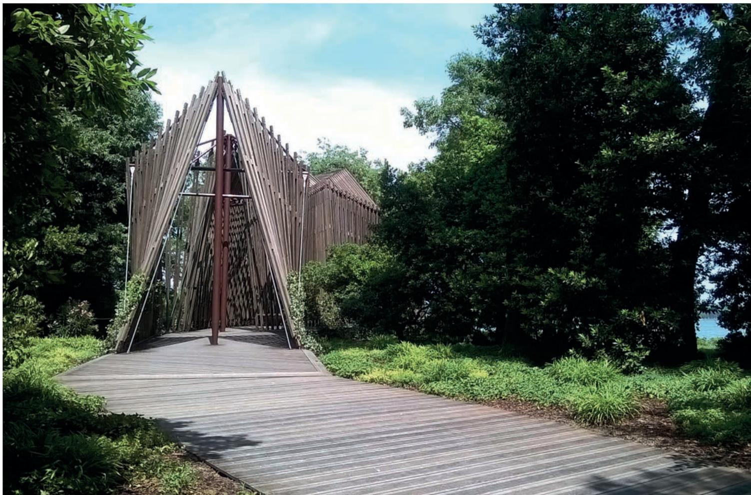
[ Foto 7. La capilla de Norma Foster cambia la dirección del camino. Se trata de una estructura de cables y puntales de acero que soportan una piel de madera. ]
