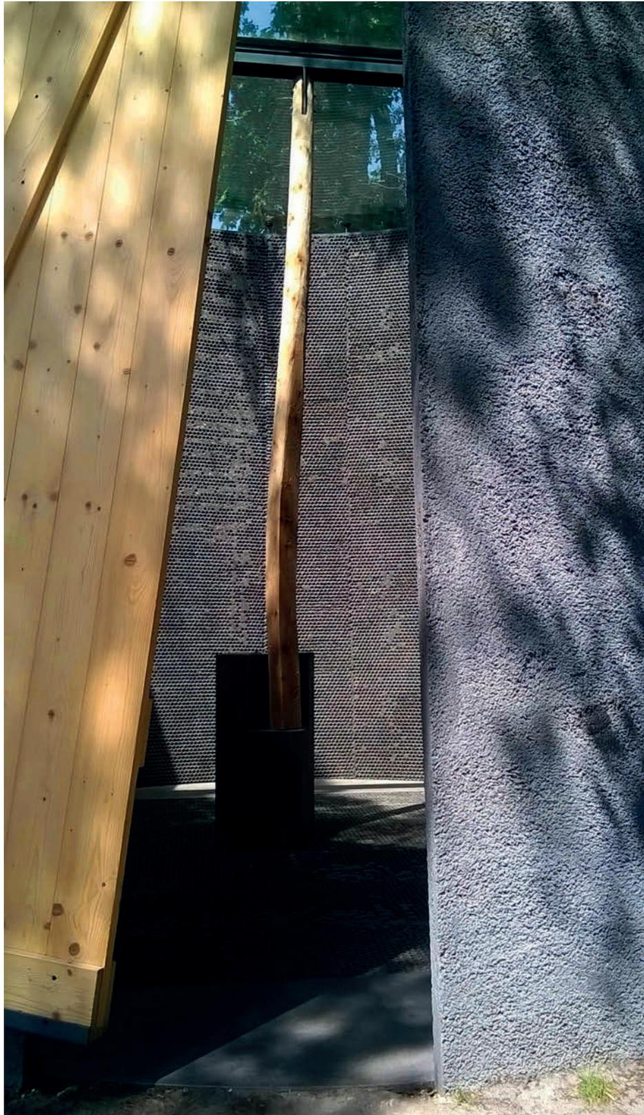
[ Foto 20. Las paredes interiores de la capilla de Radic tienen una textura muy particular porque fueron recubiertas con plástico de burbujas. ]
