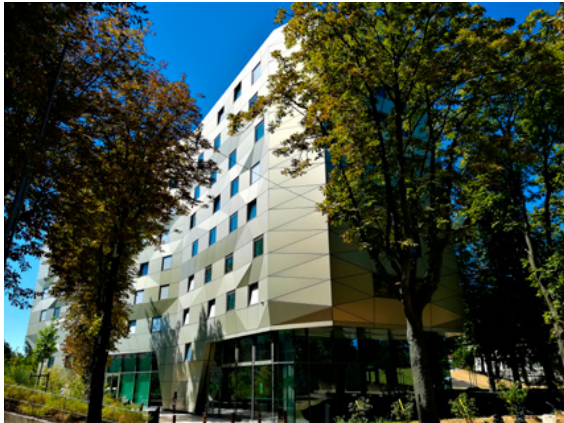
[ Figura 23. Maison de l'Île-de-France. ] Fotografía: Andrés Ávila Gómez, 2020.
