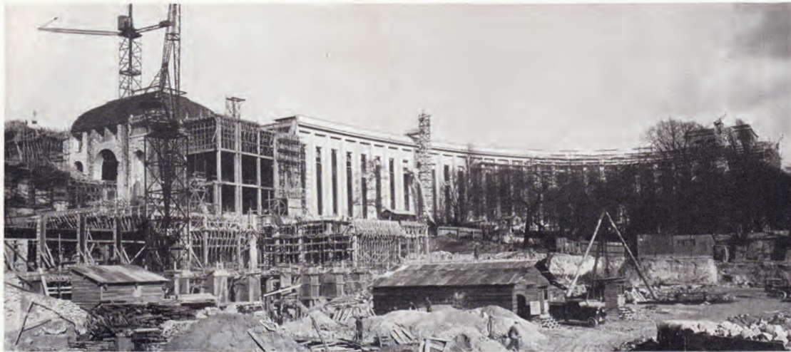
Fig. 6. — La construction de l'aile Paris. (novembre 1936).
