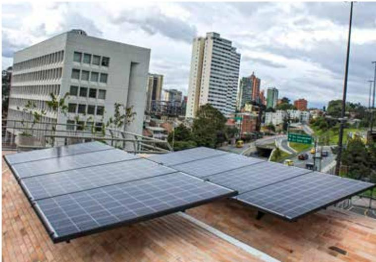
Los 24 paneles solares del CIPI están conectados a la red de energía del edificio y permiten que parte de la energía que se utiliza sea verde. En diciembre de 2016, por primera vez se logró que estos suministraran el 100% de la energía usada por el Centro de Investigaciones.
